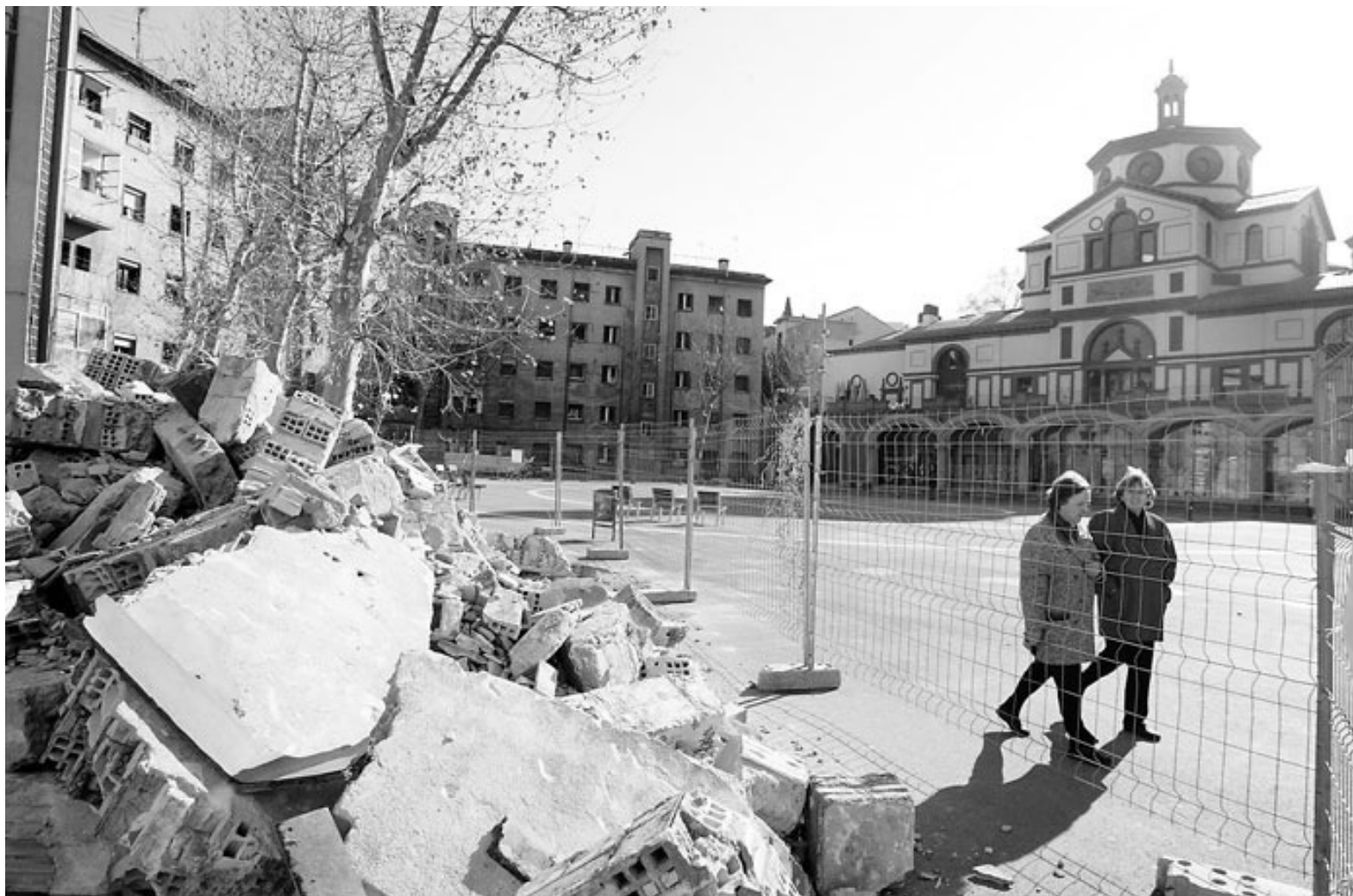
Inici de la demolició dels vells edificis de pisos, al gener del 2005. / LLUÍS CRUSET
